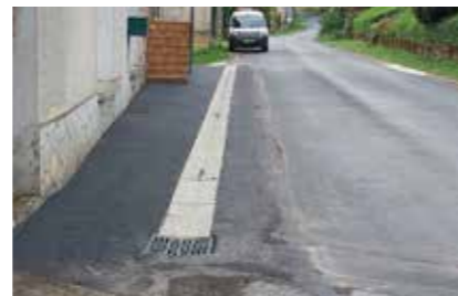
5>> travaux de traverse de chaussée et pose de CC1 à Verdon
