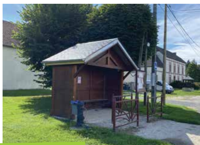
l'abribus et son nouveau toit
