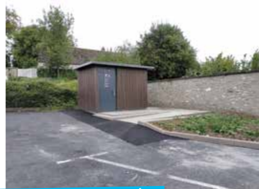
nouveaux sanitaires place de l'Église
