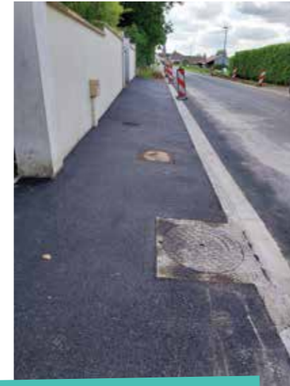
6>> travaux de voirie rue de la Bûche et assainissement pluvial à Tréfols
