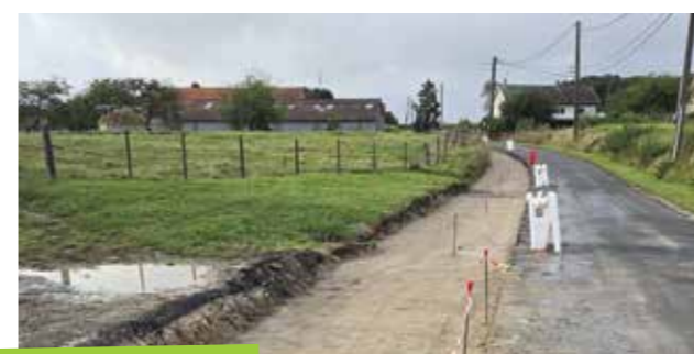
travaux rue de la Dhuis
