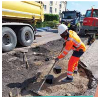
1>> remplacement du réseau d'adduction d'eau potable rue du Petit St-Lazare et rue de l'Empereur à Montmirail
