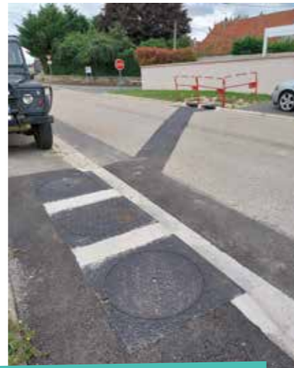
4>> travaux de voirie et assainissement pluvial rue de Beaumont à Montmirail
