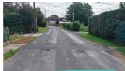
3>> travaux de voirie et assainissement pluvial RD47 à Perthuis au Gault-Soigny
