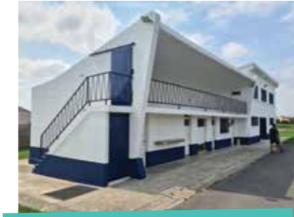
8>> ravalement de façade et peinture des murs du bâtiment du football à Montmirail
